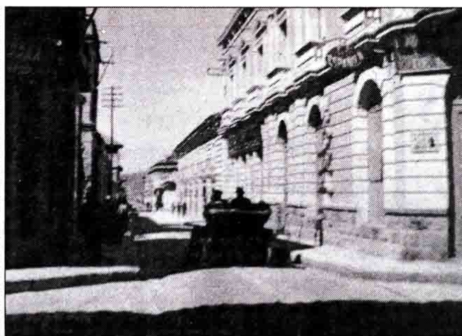
La calle Bolívar
